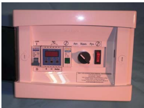
Щит управления приточной вентиляцией
